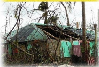
ハリケーン「マシュー」による被害
